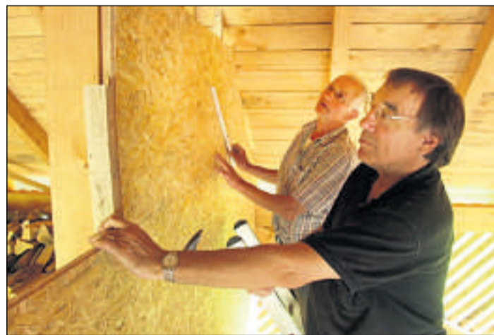
Sitzt, wackelt und hat Luft: Dietmar Herbst (vorn) und Günther Hofmann beim Einsetzen einer Zwischenwand im Schuppen.
