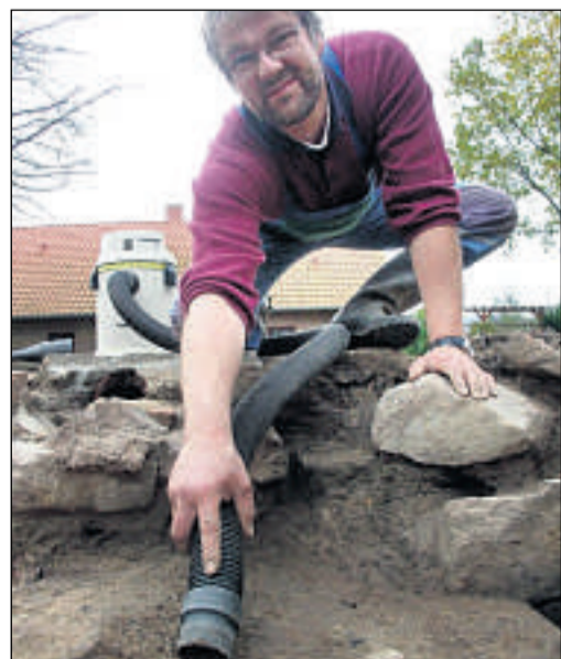
Wie Hausarbeit im Freien: Helfer Jörg Mandel aus Glashütte saugt die letzten Erdkrümel an den freigelegten Mauern der alten Kellerräume weg.
